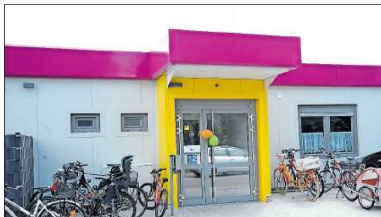
Auf das Dach der Kita Löwenherz soll eine Fotovoltaikanlage kommen. Zu viel Strom darf sie offenbar allerdings nicht produzieren, sonst gehen der Gemeinde Maxdorf Fördergelder flöten.
